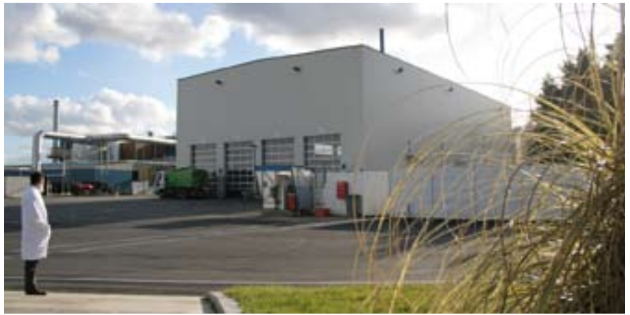
Usine de Vitré.
