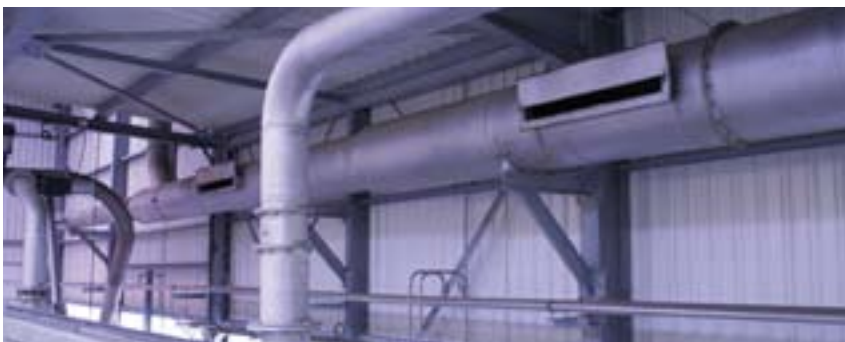
À Concarneau, le capteur d'air traite 150 000 m 3 / h.
