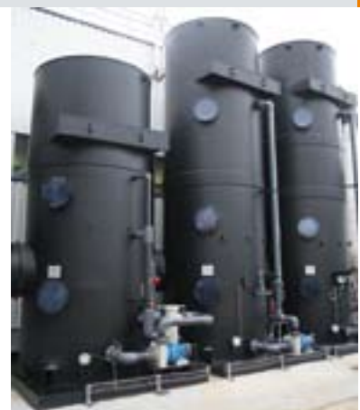
Cuves de lavage chimique.
